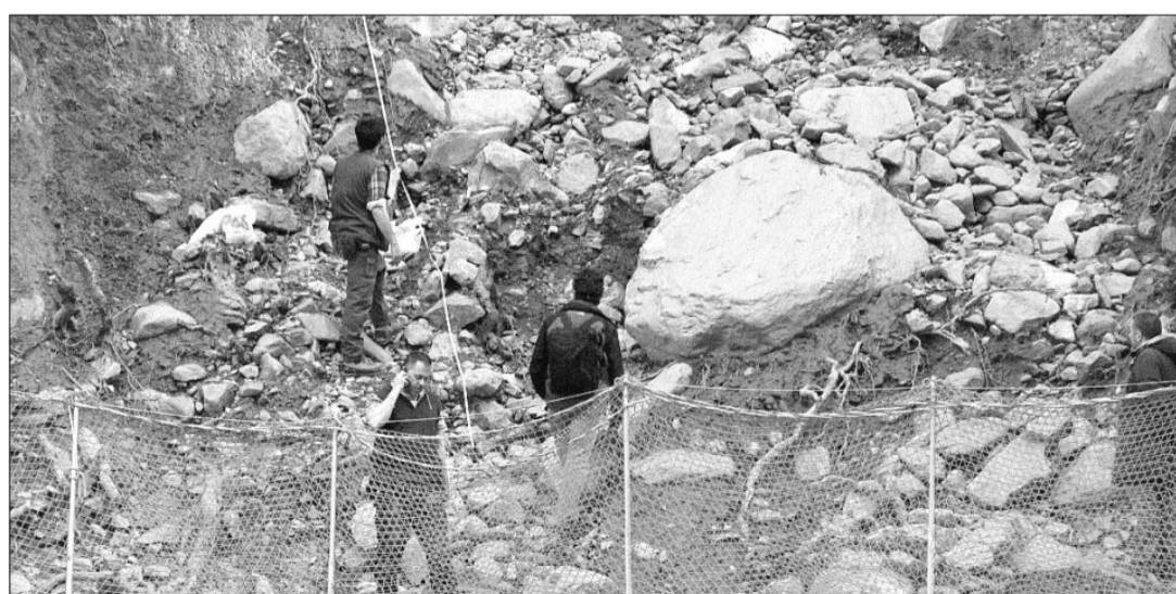
Am Berghang oberhalb des Unfallortes wird heute eine Simulation des Wassereintrittes durchgeführt.
